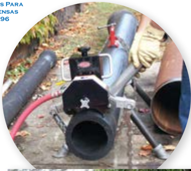
UPC cortando PE
